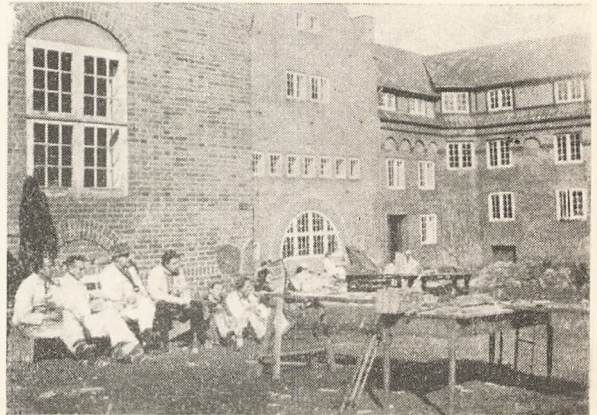
Frokosthvil under Reparationsarbejdet.
