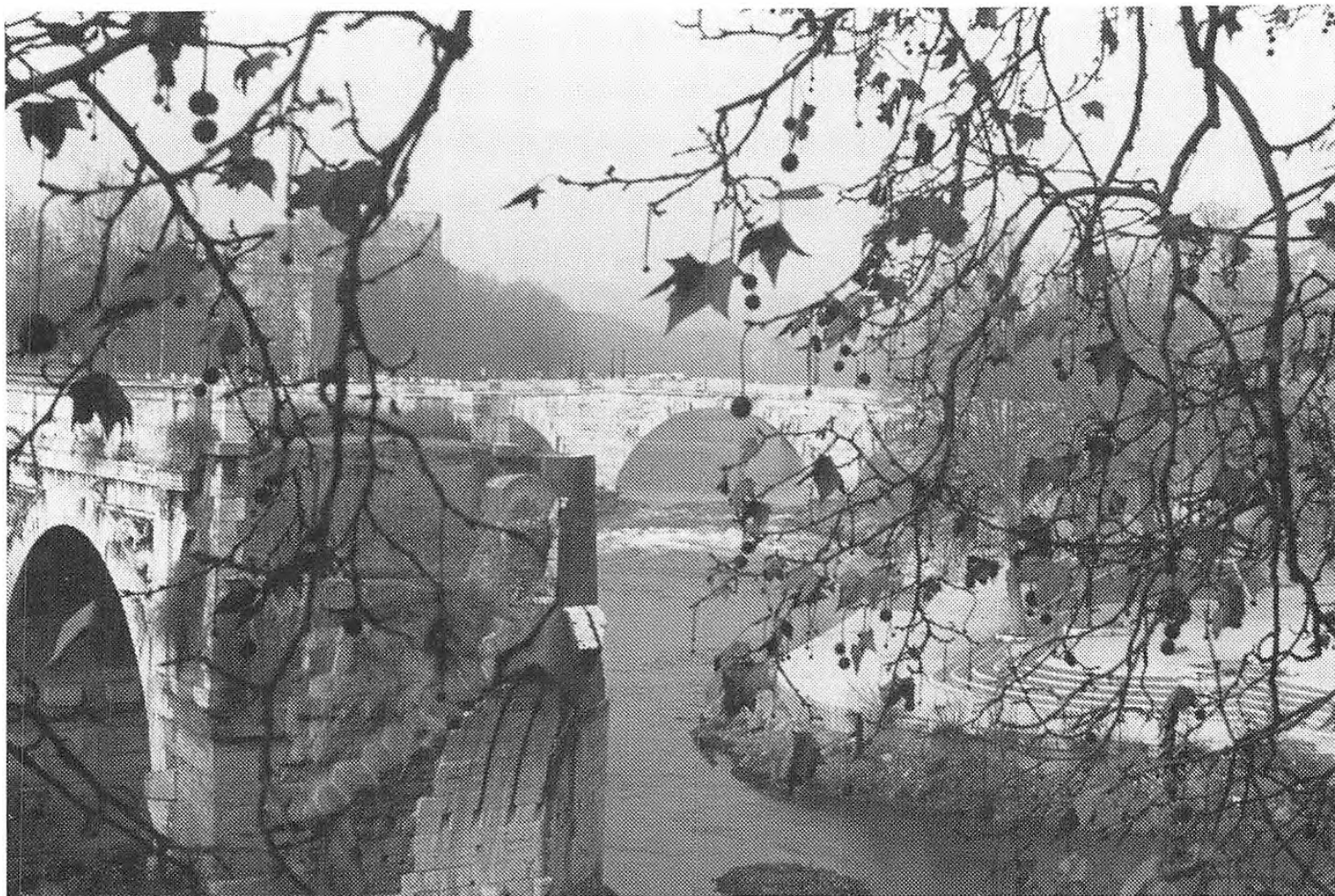
Ponte Rotto i Rom.
