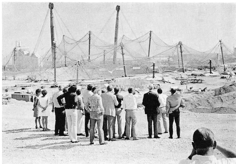
Tagkonstruktionen på idrætshallen
